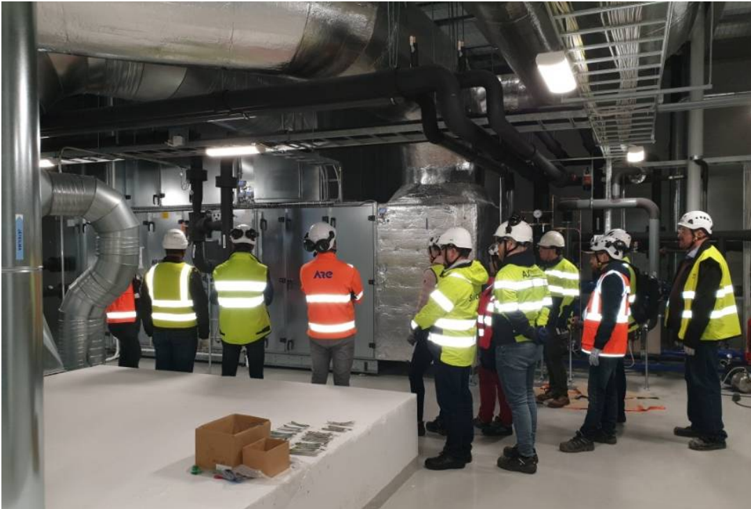
B-rakennuksen ilmanvaihtokonehuoneessa. Valokuva Ari Oranen.
